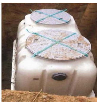
合併浄化槽の設置
