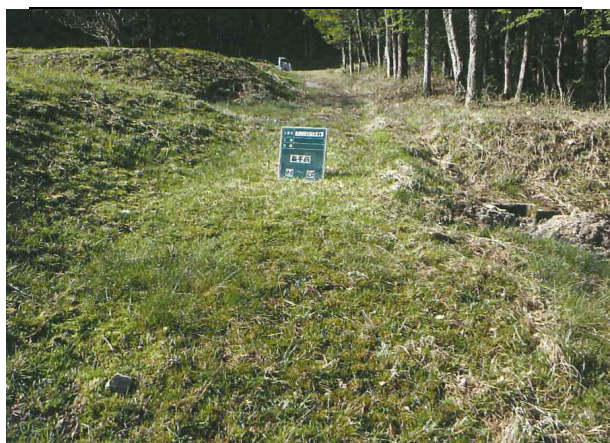
津具地区 農道改良工事 着手前
