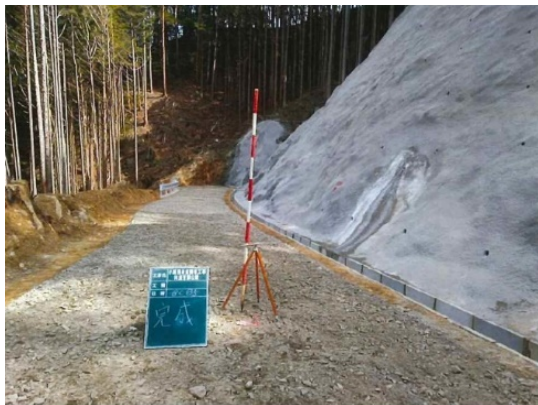
林道笹頭山線 開設状況
