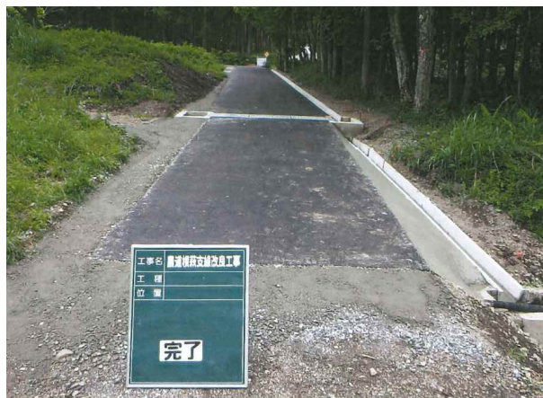
津具地区 農道改良工事 完了
