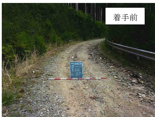
舗装工事を進めている林道三都橋線（三都橋地内）
